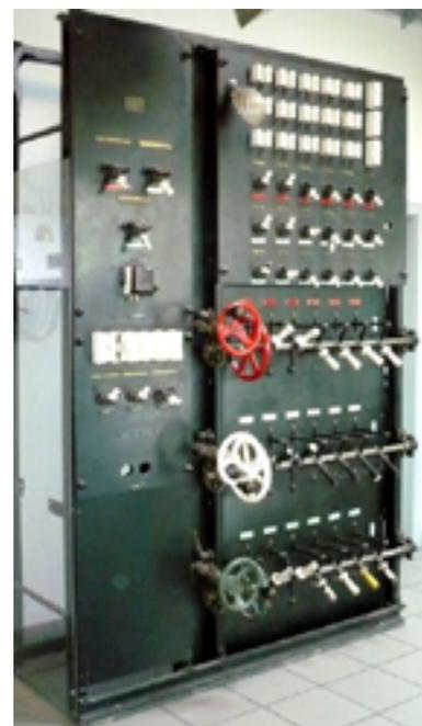
Bild 32: Eines der frühen Stellwerke von Strand Electric befindet sich im Scheinwerfermuseum, auf der Vorderseite sind alle Wellen, Hebel, Sicherungen und Schalter, auf der Rückseite die Widerstände.
