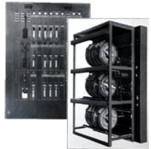
Bild 16: Equipment des Cutler-Hammer „Simplicity“ Dimmers mit Hauptschaltpult. Diese Ansicht zeigt sehr gut die direkte Steuerung, die möglich ist, wenn die Dimmer direkt hinter dem Schaltpult eingebaut sind.
