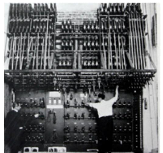
Bild 8: Ungewöhnliche Form der Installation zwecks besserer Anwendbarkeit von Cutler - Hammer „Simplicity“ Dimmern. Alle Betriebshebel sind in Reichweite.
