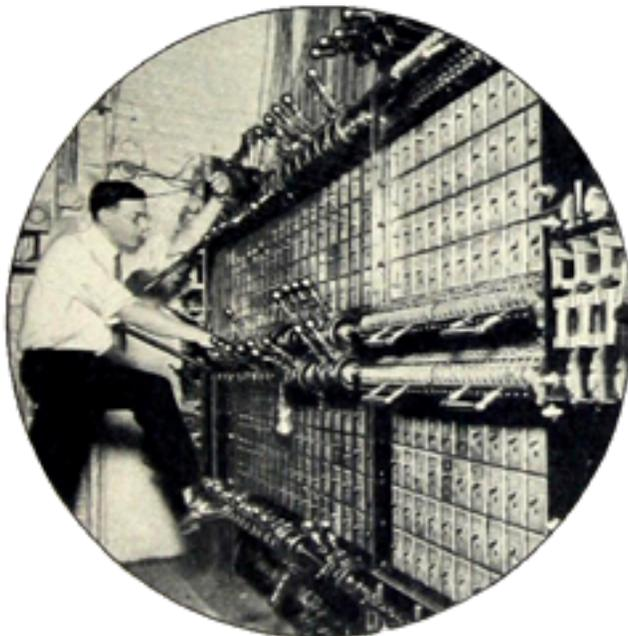
Bild 10: Diese Abbildung verdeutlicht den mitunter speziellen Bedienungsaufwand an einem dieser Stellwerke, hier an einem Stellwerk von Ward Leonard mit 5000 Ampere, es gab auch Anlagen mit 10.000 Ampere im Dreileiter - Gleichstrom - System. Die folgenden Abbildungen zeigen verschiedene Bauformen für Anwendungen in kleinen und mittleren Anlagen.
