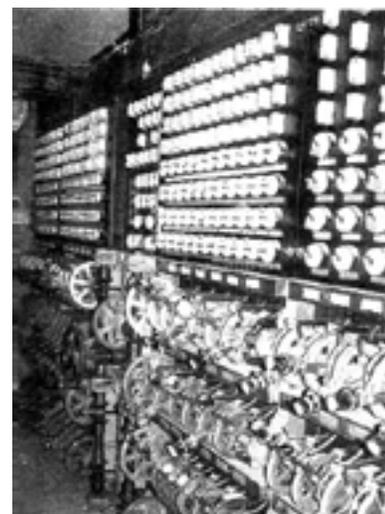
Bild 31: Strand Electric baute ebenfalls Stellwerke mit direkt hinter der Tafel montierten Dimmern, Typ „Grand Master“ mit 250 Stellkreisen.
